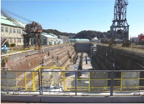
図4 世界的にも珍しい煉瓦積みのドライドック。前方がゲート。右側のクレーンは頭部がなく赤錆びていた（旧浦賀ドック 2014）
