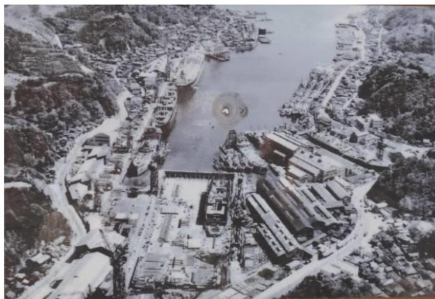
図3 1950年頃の浦賀ドック。中央に見える2本の進水台のうち右側が日本丸IIの進水に使用された。更に右側斜めの部分がドック。浦賀駅はこの写真のすぐ下側。屋外説明板を筆者撮影。
